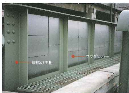
磁力を利用した制振材「マグダンパー」
