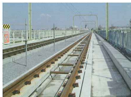
フローティング・ラダー軌道
