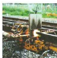
小型レールガス圧接機による レール溶接
