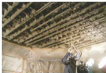
吹付け修復工法 「JOT'S Crete (ジョッツ クリート)」
