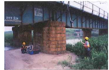
衝撃振動試験状況
