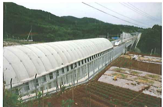
緩衝工によるトンネル微気圧波対策実施例
