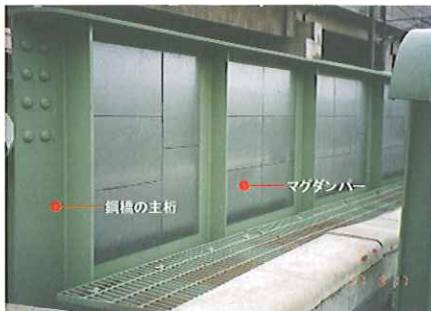
磁力を利用した制振材「マグダンパー」
