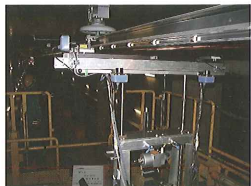
電車線の架設精度測定例
