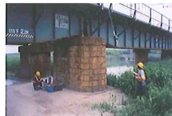
衝撃振動試験状況
