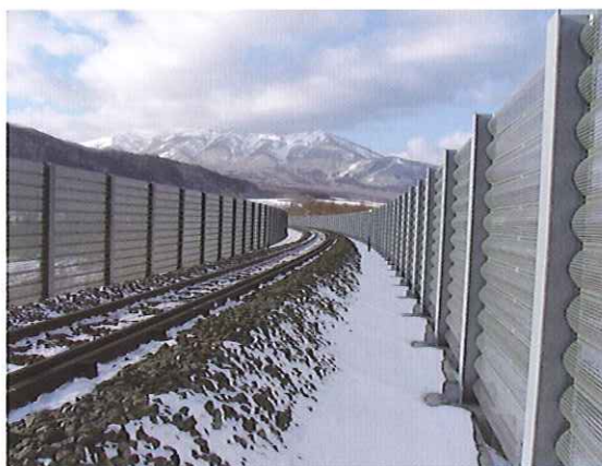
風洞試験により検討した防風柵を 施工した例 (JR北海道)
